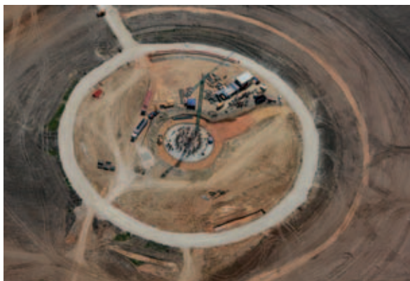
Avance de las obras en la planta Gemasolar.
